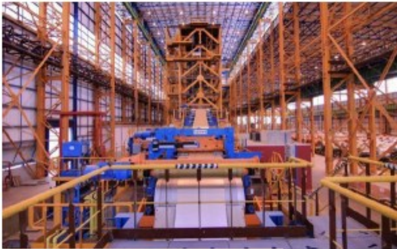
Planta de ArcelorMittal en La Vega do Sul (Brasil). EXPANSION
